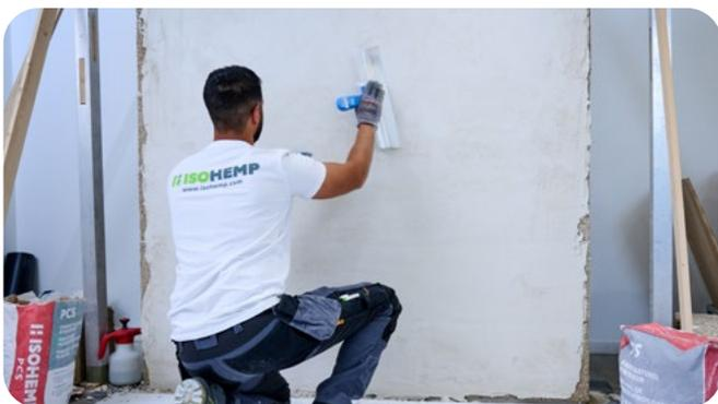
Pour obtenir un effet miroir parfaitement lisse : quand le mur est bien sec et dur, le lendemain, mouillez avec un pulvérisateur le support et repassez une dernière fois au couteau à lame souple. Cet ultime passage permet d'enlever les dernières imperfections.
