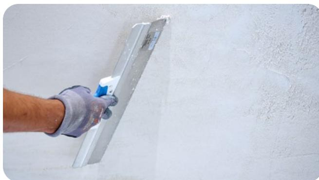
Si après le second dressage il y a encore des imperfections, laissez et reprenez avec le couteau. Attention de ne pas déstructurer l'enduit en travaillant trop ce dernier.
