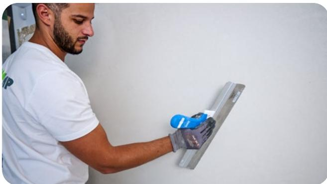
Polissez ensuite avec un couteau à enduire à lame souple et flexible. Cette étape permet d'enlever la laitance.
