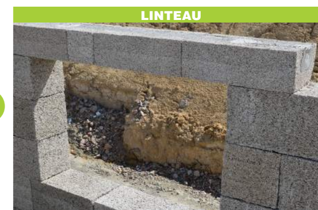
Utilisation des linteaux IsoHemp pour supporter les charges au-dessus de chaque ouverture*.
