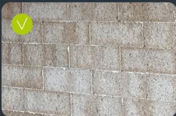
Bon traitement des joints
