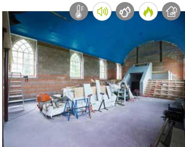
**Proyecto :** Renovación a baja energía de una iglesia antigua. Aislamiento interior hecho con bloques de 30cm. Calefacción mural y acabado interior en arcilla.
