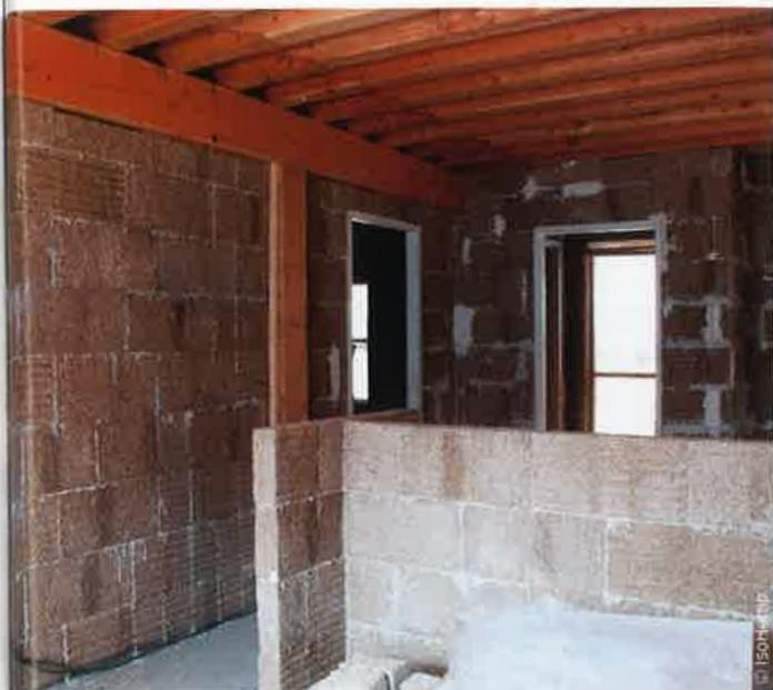
s'assemblent facilement à l'aide d'un joint mince de 3 mm en mortier-colle. Un bloc un peu trop long ? Un simple coup de scie suffit pour lui donner les dimensions voulues. Le matériau est léger, et donc agréable à travailler et rapide à mettre en œuvre ; à base de composants naturels, il ne dégage aucune odeur désagréable et peut être manipulé sans protection spécifique. Ces différentes qualités en font un matériau particu-
