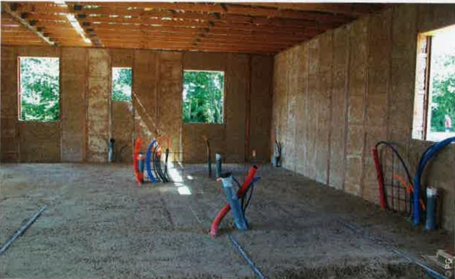
Les atouts du mélange chaux-chanvre sont nombreux. Il s'agit en effet d'un produit naturel et respectueux de l'environnement, qui présente de surcroît d'excellentes qualités de confort thermique et acoustique, et régule efficacement le taux d'humidité au sein de la construction.
